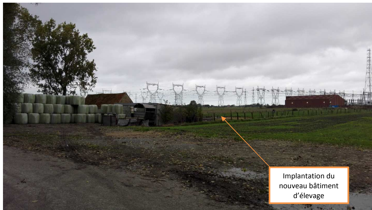
Figure 8. Vue depuis le chemin de la Warande, au Sud-Ouest du projet
